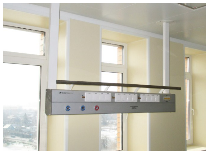
Рис. Консоль тип потолочный мост МК-НД-1600 (зав.инд. ПП)
