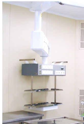
Рис. Горизонтальный приборный блок шириной 800мм
